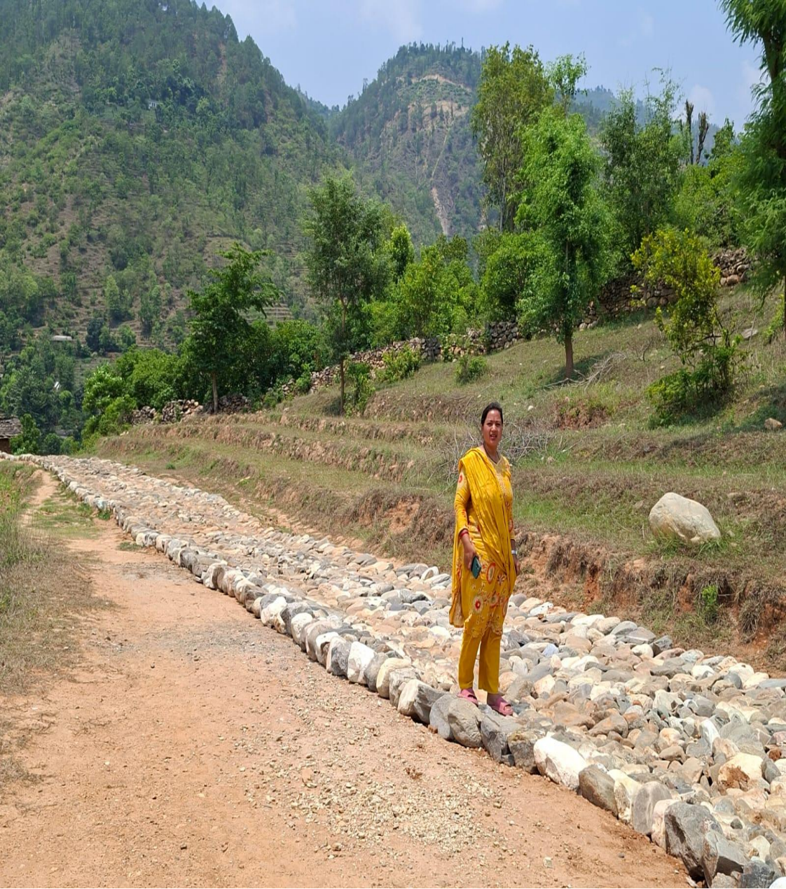
खाल देहिमाण्डौ हुदै राडिल सम्म सोलिङ्ग निर्माण
